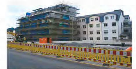
Der Neubau nimmt Gestalt an: Blick auf den Standort Boppard im Juni 2012.
