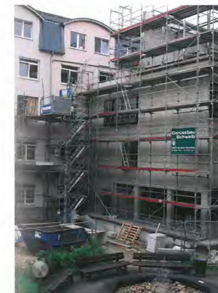
Rohbau-Ansicht des neuen OP.
